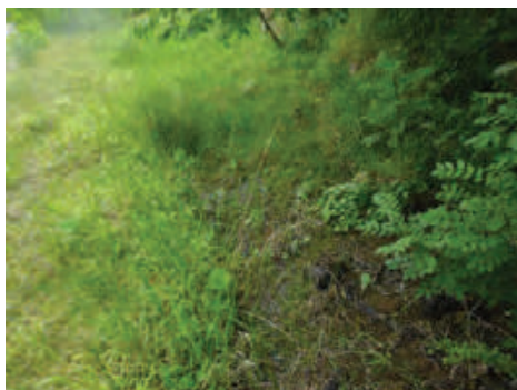
Zone de suintements
